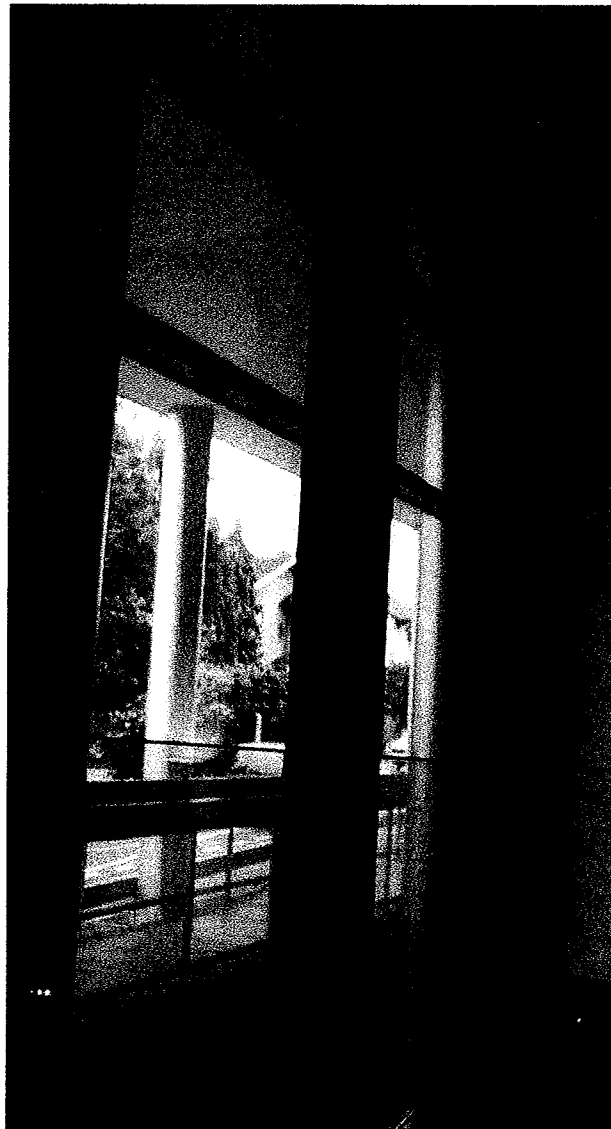
Façade mur-rideau Vue de l'intérieur
